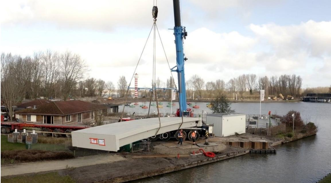
Abbildung 3: Einhub des Überbaus in Almere, Niederlande 2022
