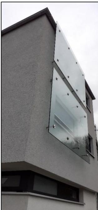
Abbildung 8 – Vorgehängte Glasfassade<sup>1</sup>
