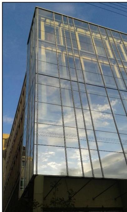
Vorgehängte Glasfassaden oder Prallschreiben stellen eine Möglichkeit dar für einen adäquaten Schallschutz zu sorgen und werden aufgrund der Höhe der Schallimmissionen (Überschreitung der Schwellenwerte der Gesundheitsgefährdung nachts) eingehend empfohlen.
