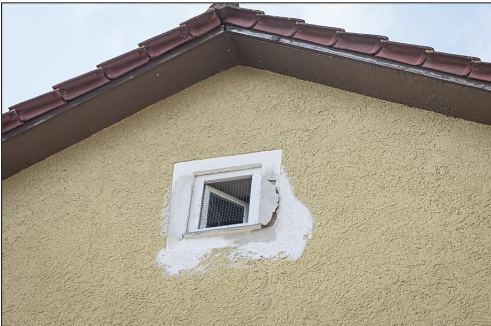
**Abb. 6:** Gebäude Nr. 127 mit offenem Giebelfenster und Spalt hinter der Firstscheibe
