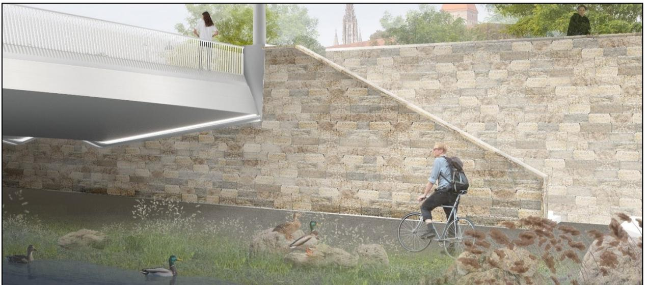
Abbildung 4: Blick auf das Widerlager Ulm mit neu errichteten Stützwänden
