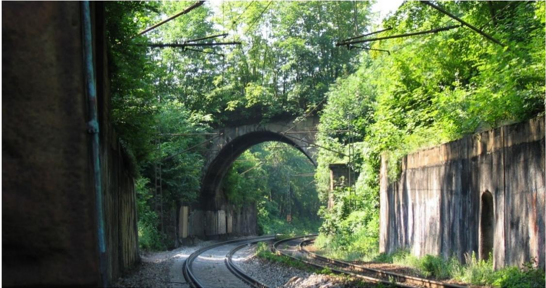
Das Gewölbe und die anschließenden Flügel (Baujahr 1946) sind beidseitig auf den Mauerwerken der alten Festungsanlage, die als Seitenwände dienen, aufgelagert (Baujahr 1932); diese sind wiederum flach geründet.
