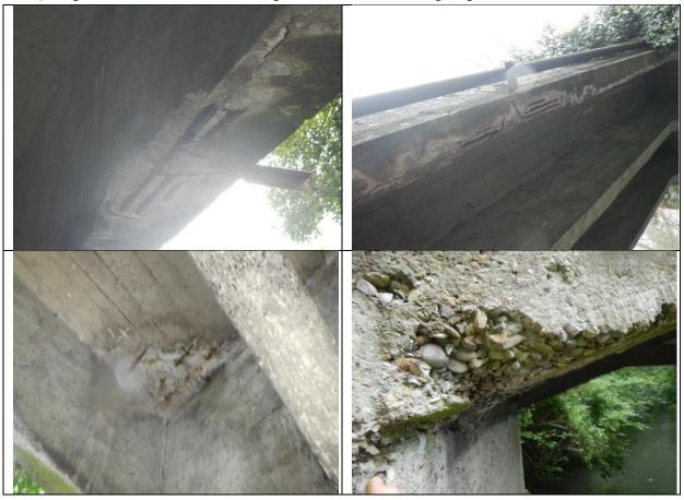
Schäden an der Brüstung und am Geländer
