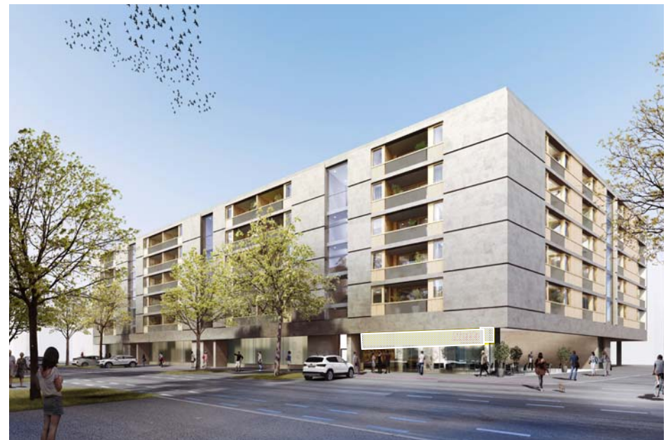
Söflingerstraße / Ecke Kässbohrerstraße
