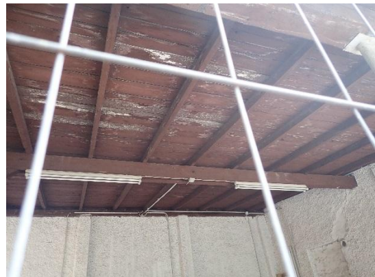
Detail Carport/Schuppen: keine Vogelnester; kein zugluftsicherer Unterschlupf für Fledermäuse
