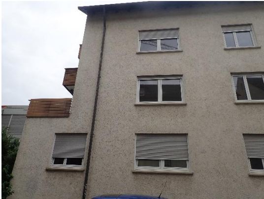
Wohnhaus an der Karlstraße: keine Vogelnester unter Dachvorsprung; Holzverkleidung am Balkon „zugig und lückig“, ohne Schutzfunktion für Fledermäuse
