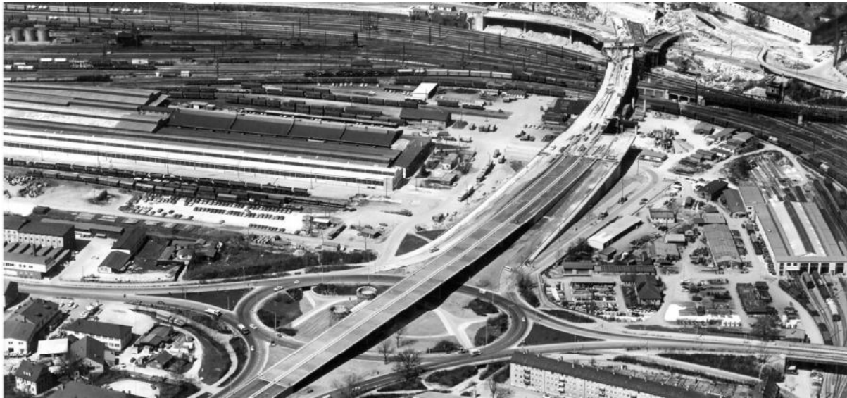
Abb. Luftbild vom Bau der Wallstraßenbrücke
