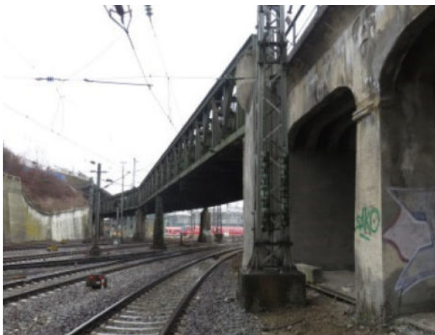
Abb. Gitterbrücke DB Netze AG über Strecke 4540, 4541 und 4553
