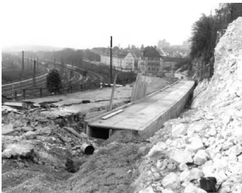
Abb. Bauzustand Medienkanal am nördlichen Widerlager der Wallstraßenbrücke
