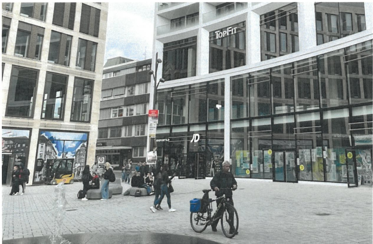
Detail Sedelhöfe | Die zweigeschossigen Läden links und rechts stehen leer
