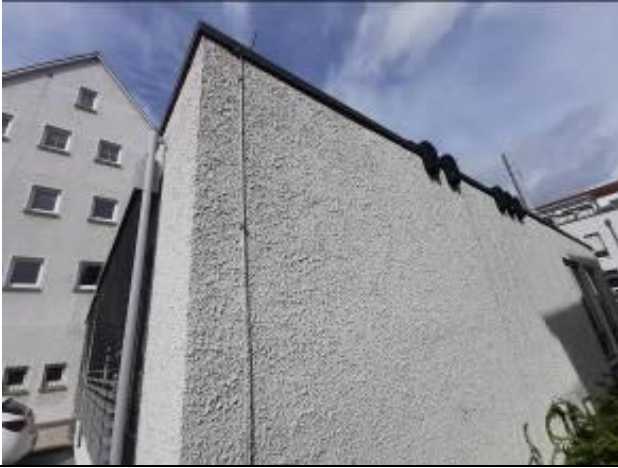
Nebengebäude mit Fledermauskästen
