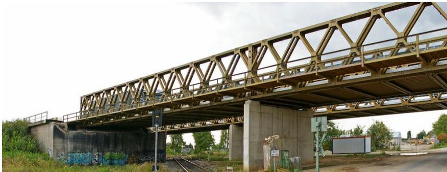
Abb. Beispiel für eine Behelfsbrücke
