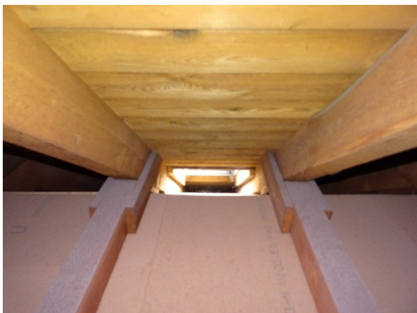
... und durch Luken über den Dachfenstern darunter auch teilweise hell.
