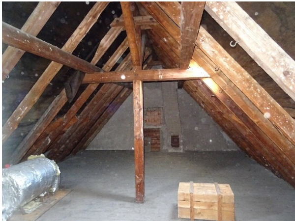
Im östlichen Teil war das Gebälk bis zum Spitz vollständig offen, das Dach selber mit Brettern und Dachpappe abgedichtet.
