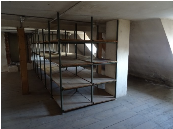
Auch die Dachböden waren bis vor Kurzem genutzt.
