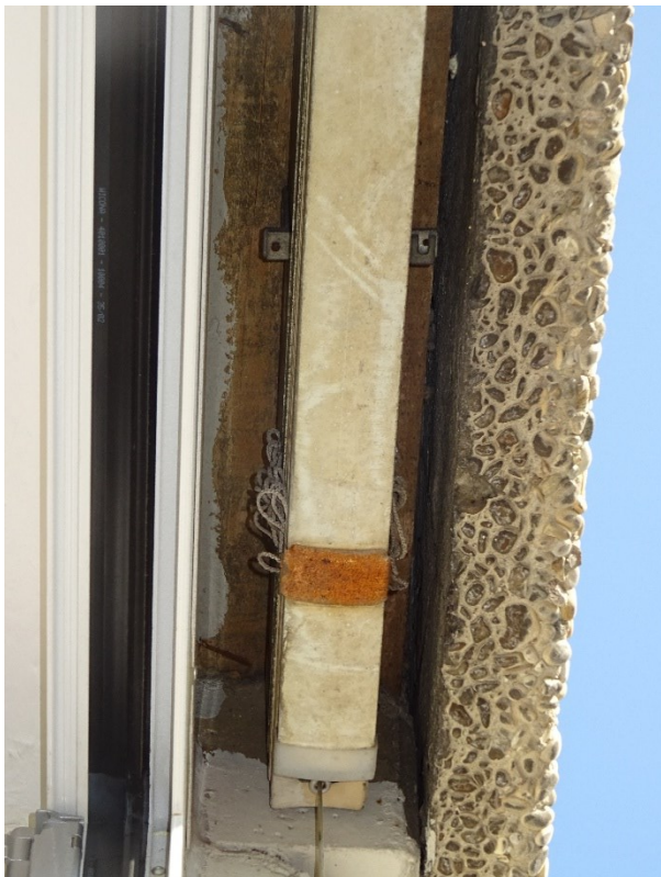
... ein gut 1 cm breiter Spalt zwischen Wand und Fassadenplatte, ...
