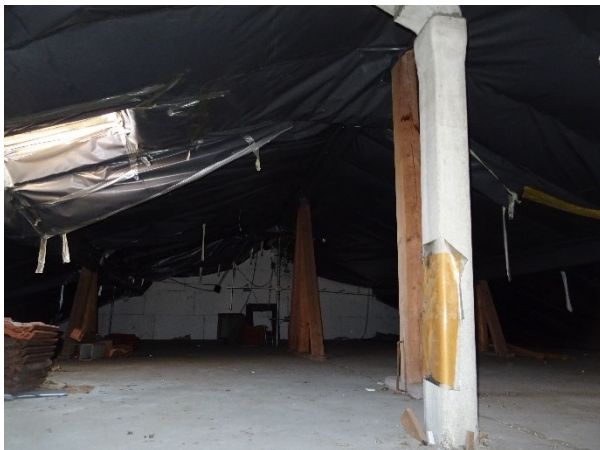
Der Dachboden hier war isoliert und mit Folie verkleidet,
