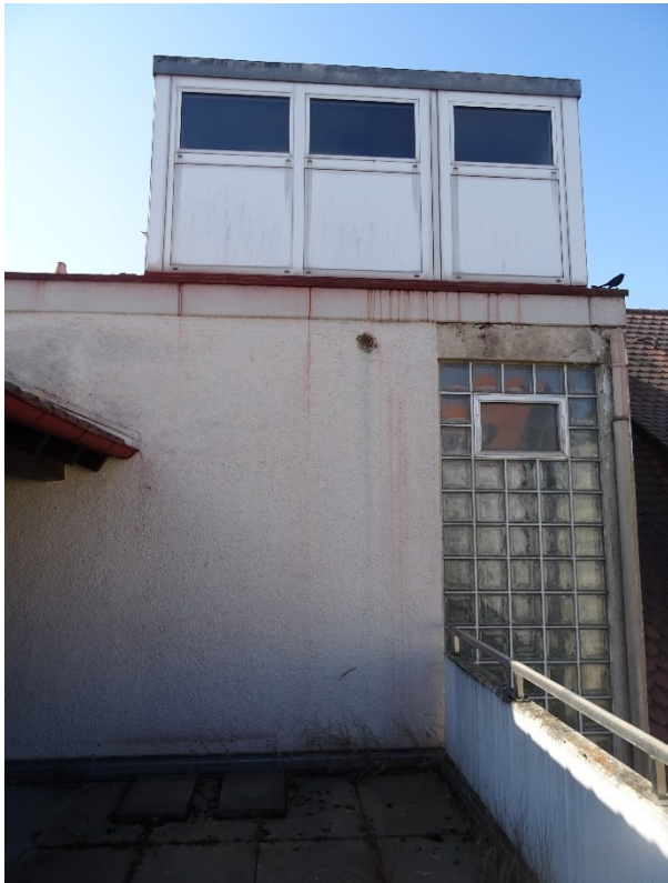
Blick von der Dachterrasse nach Süden auf den vorhin schon gezeigten Aufzugs-Aufbau. Rechts am Rand sitzt ein Hausrotschwanz, der vermutl. das Nest gebaut hat.
