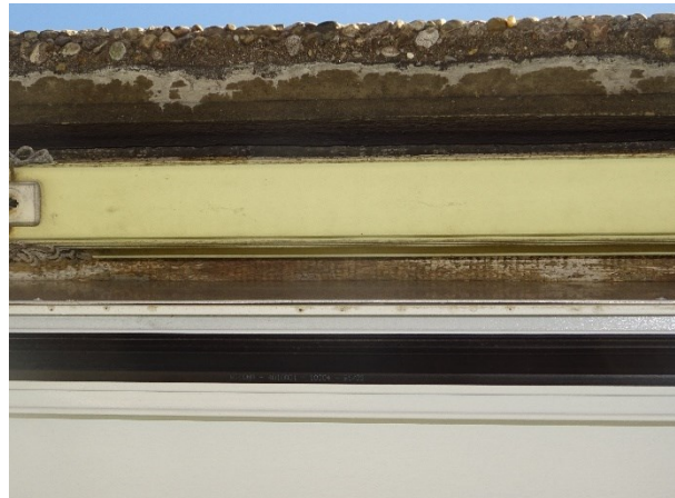
Fassade Südseite; die Waschbeton-Platten (oben) ...
