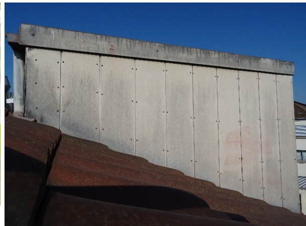
Dieser Aufbau von außen. Der Überstand ist dicht.
