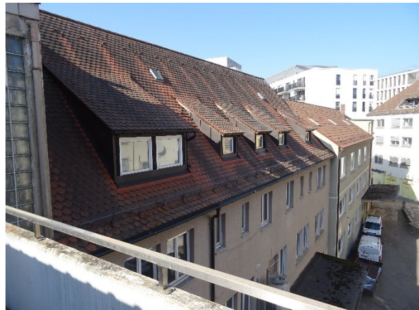
Nordseite, von der Dachterrasse Wengengasse aus, mit verblechten, dichten Dachgauben ...
