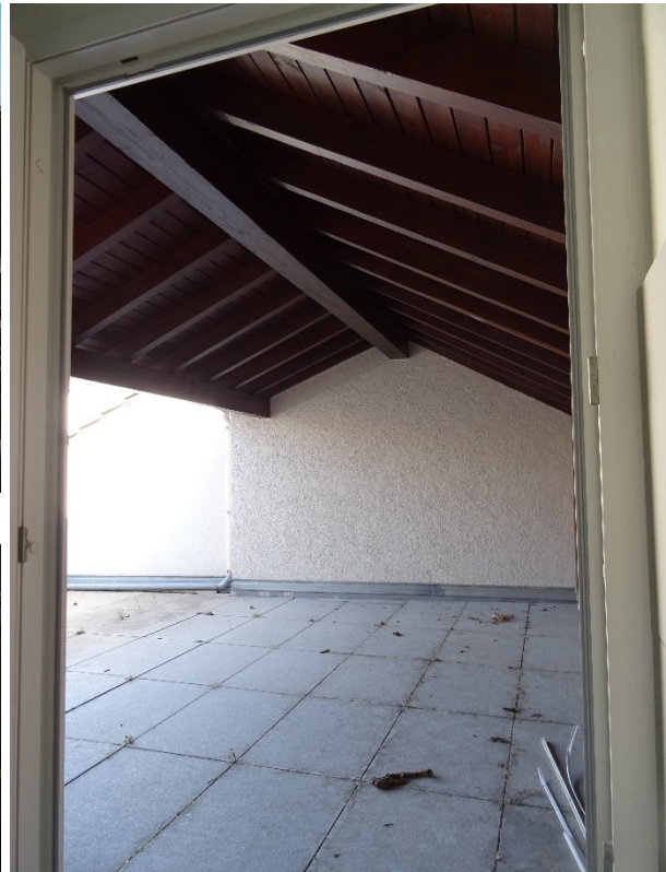
Dachterrasse im etwas niedrigeren Nordteil ..
