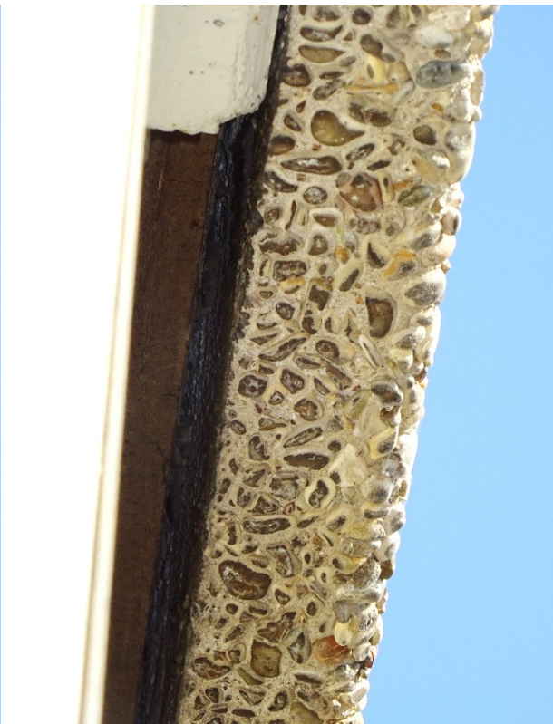
... ein gut 1 cm breiter Spalt zwischen Wand und Fassadenplatte, ...
