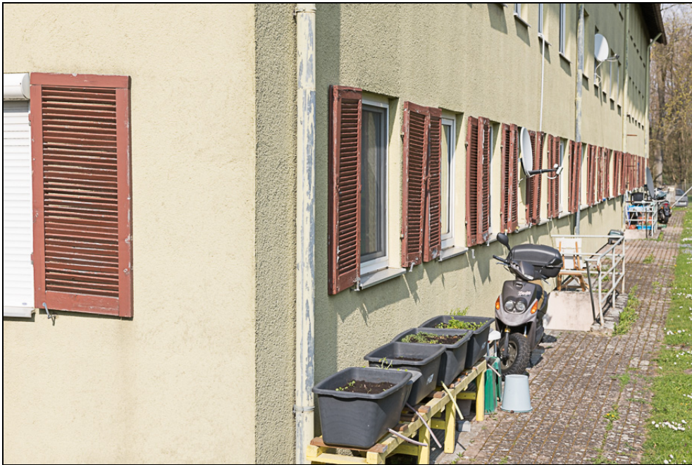
Abb. 3: Lamellenfensterläden als potenzielle Fledermausquartiere (21.04.2021)
