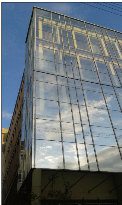
Abbildung 8 – Vorgehängte Glasfassade 1
