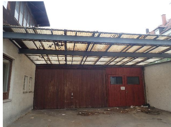
Garage als Abschluss der Innenhofes (von Wildstraße): keine Vogelnester, kein Lebensraum für Fledermäuse
