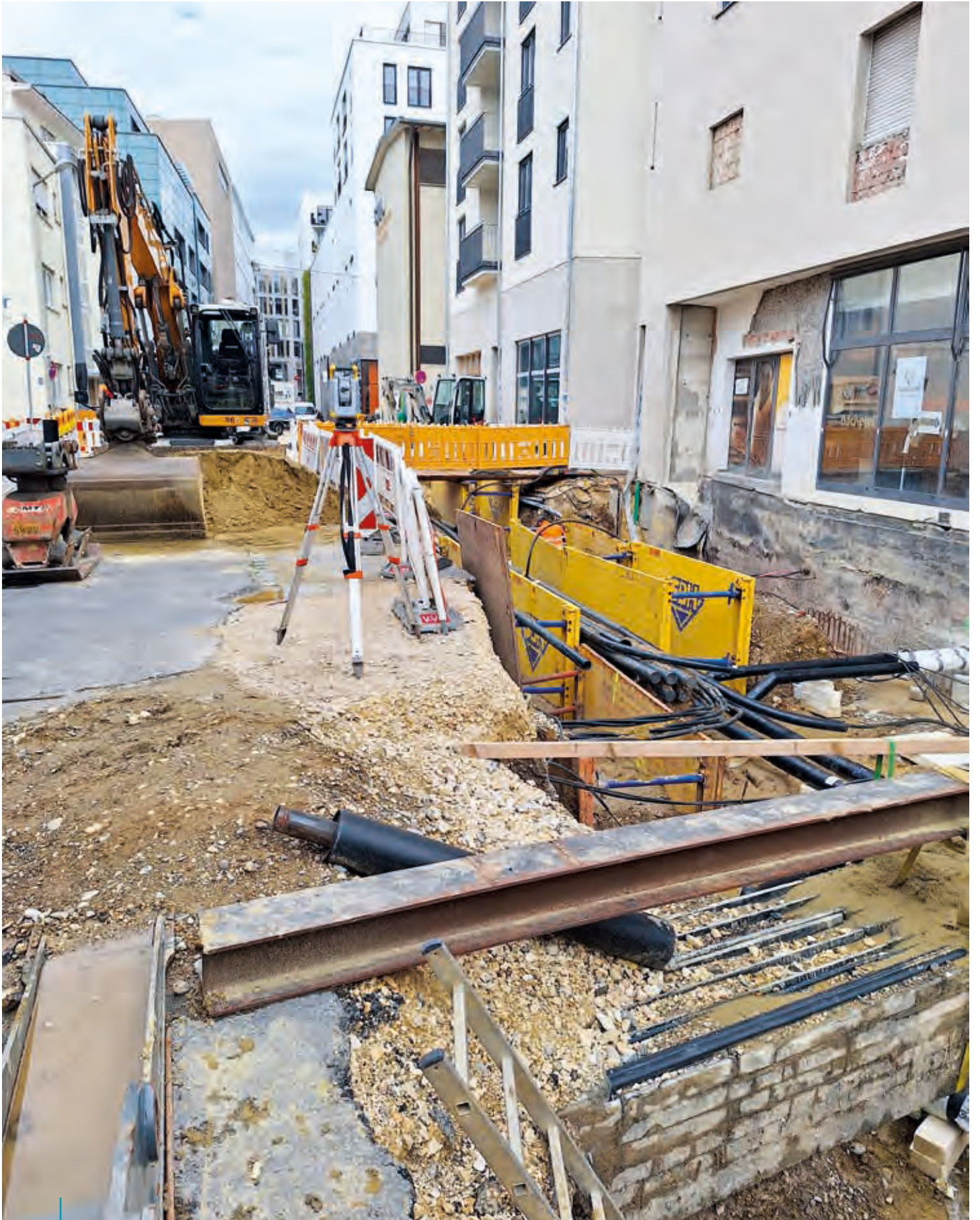
Wengenviertel Kanalerneuerung in geschlossener Bauweise © EBU
