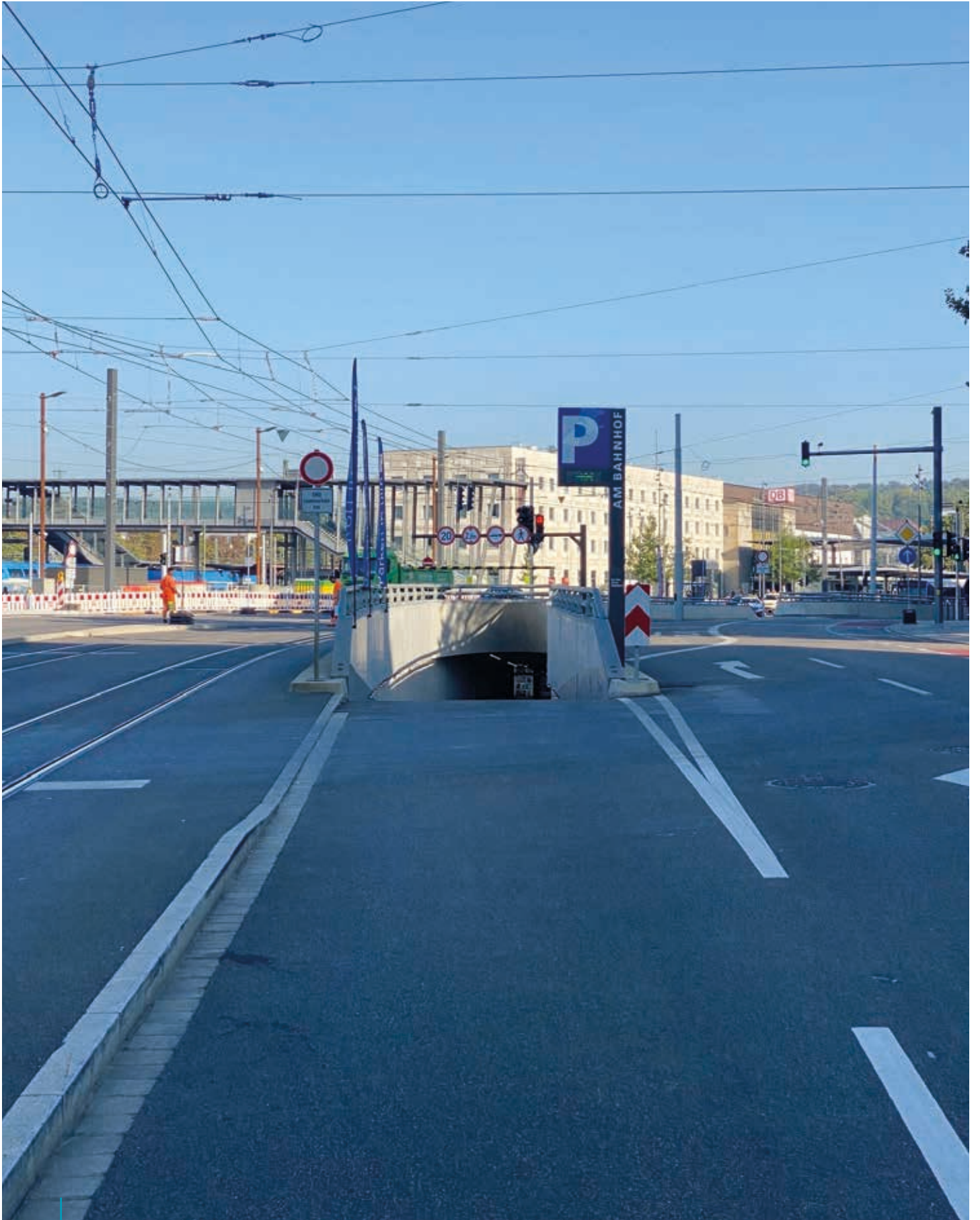
Parkhaus Am Bahnhof, Einfahrt Süd © Ulmer Parkbetriebs-Gesellschaft mbH
