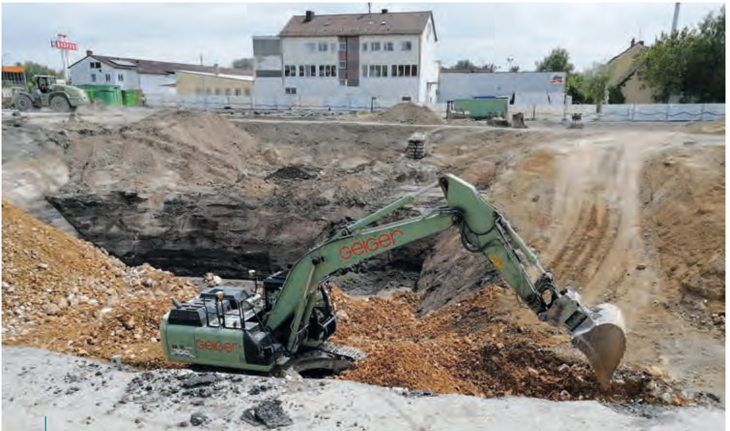
Kurz vor dem Abschluss: Altlastensanierung auf dem ehemaligen Braun-Areal © Sanierungstreuhand
