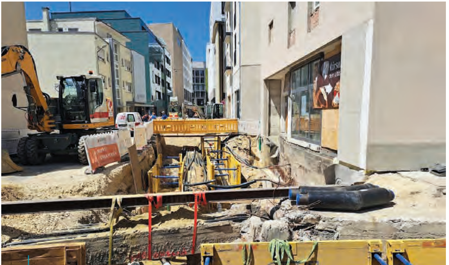
Umbau des öffentlichen Raums im Sanierungsgebiet „Wengenviertel“ © Sanierungstreuhand
