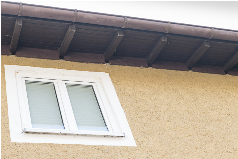
Abb. 7: Ostseite von Gebäude Nr. 127 mit 22 Höhlenstrukturen (21.04.2021)
