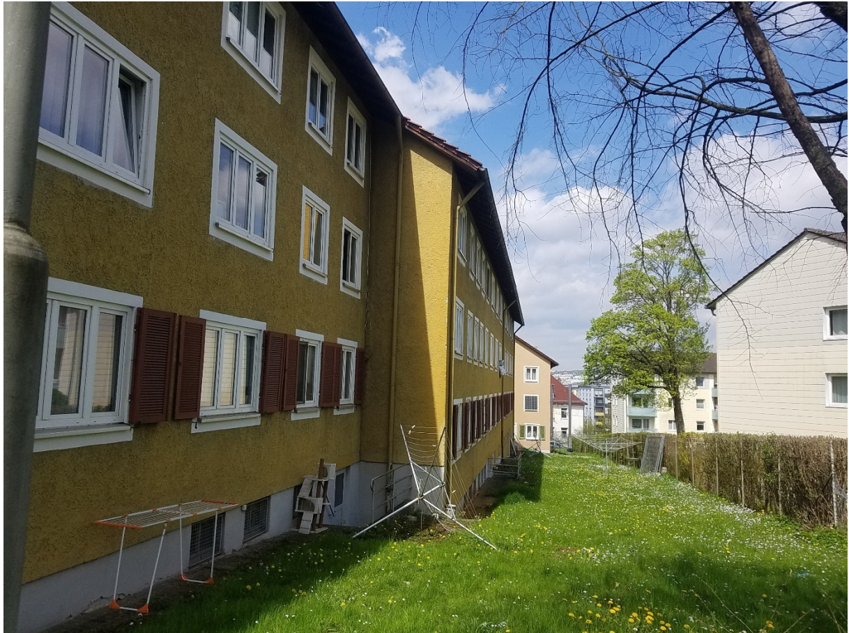
Abb. 2: Beispielsbild der Gebäude 119-127 (Ostseite) mit Fensterläden, Ortgangziegeln als pot. Spaltenquartiere
