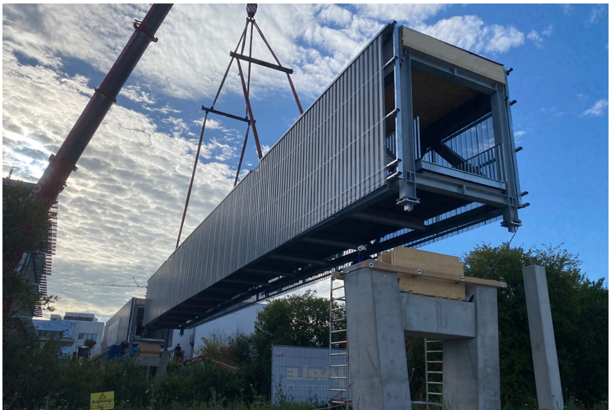
Montage des 36 m - Brückenteils
