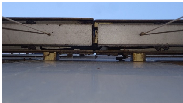
Blick von unten nach oben: Auf die Fassade aufgesetzte Jalousienkästen.
