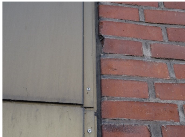
Auch dieser Übergang zwischen Metall und Backstein ist durch eine Dichtung ohne Spalt.
