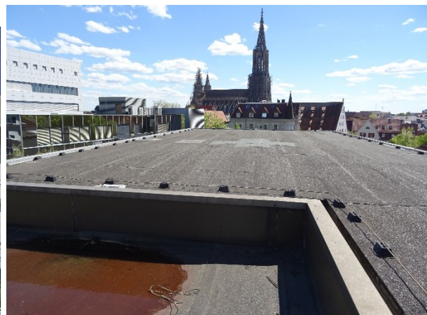
Flachdach mit umlaufenden, dichten Attikablechen.
