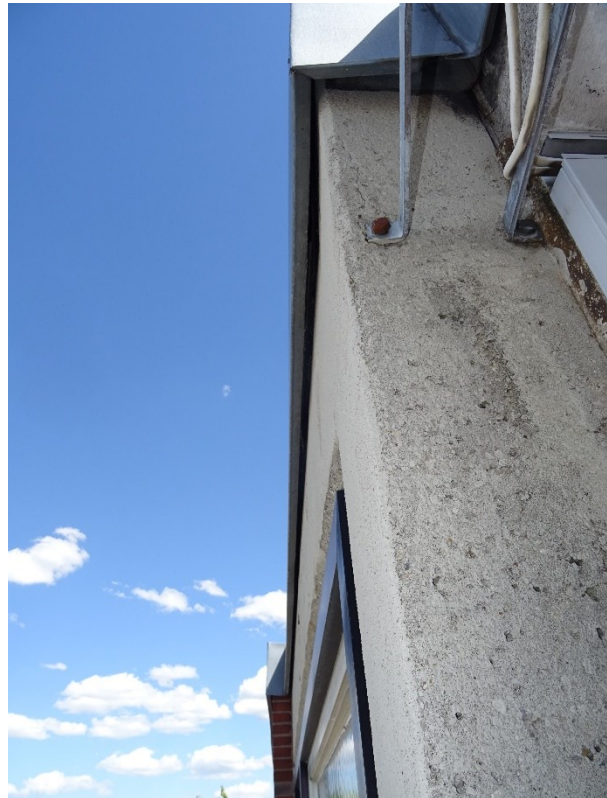
Dto. Blick von dieser Terrasse von unten auf die Attikableche, diese dicht und ohne Spalten.
