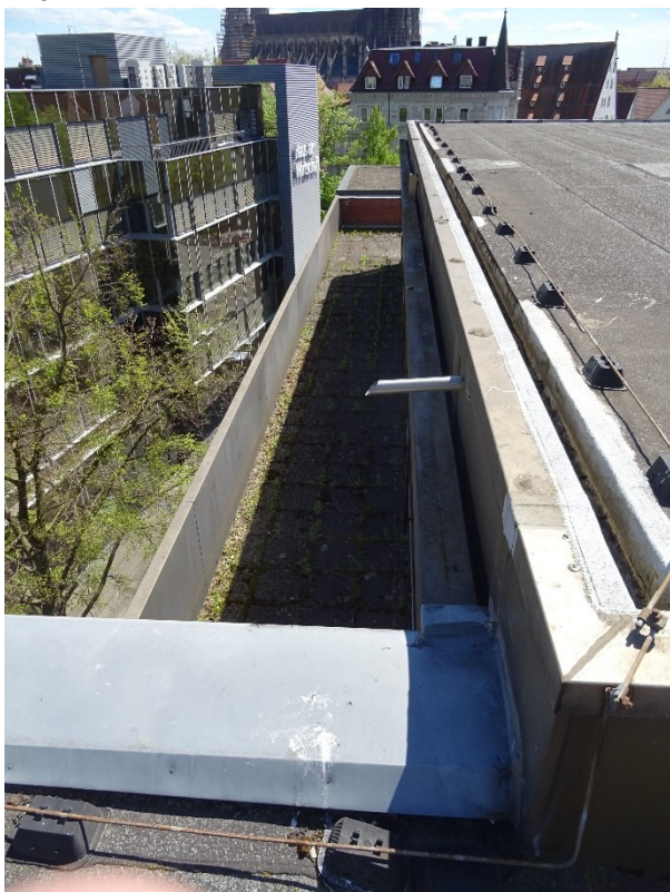
Dachterrasse auf der Ostseite, Blick von oben.
