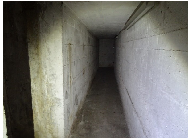
Schräg vom Haus weg verlaufender Tunnel ...
