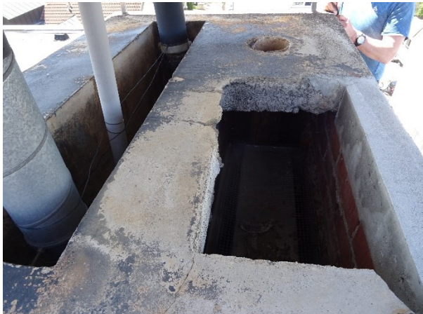
Ehemaliger Kamin, leer bzw. Spinnweben.
