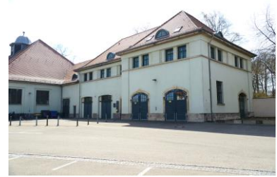
Gebäude, andere baustelle ulm e.V.
