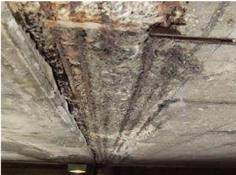
**Tunneldecke: Betonabplatzung mit freiliegender Bewehrung**
