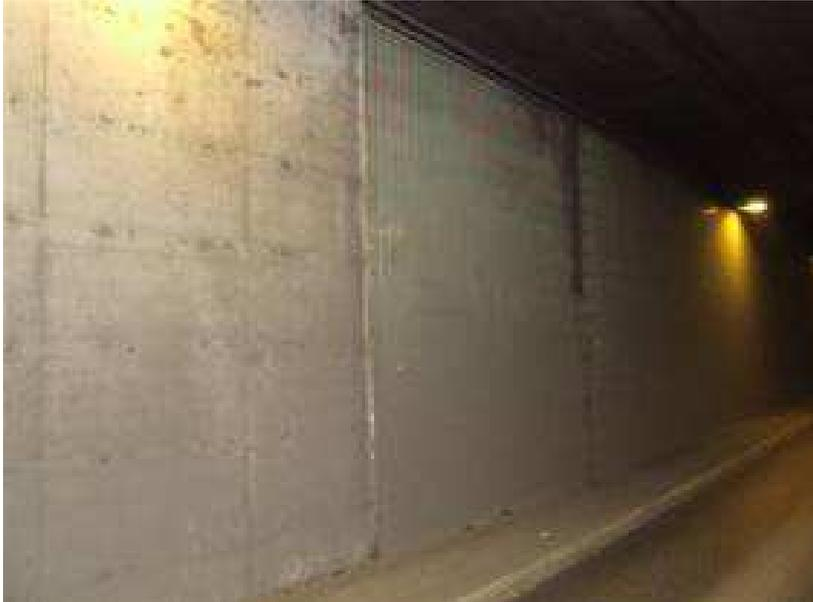
**Verkleidung der Tunnelaußenwand mit Fliesen: Fliesen sind großflächig abgeplatzt**
