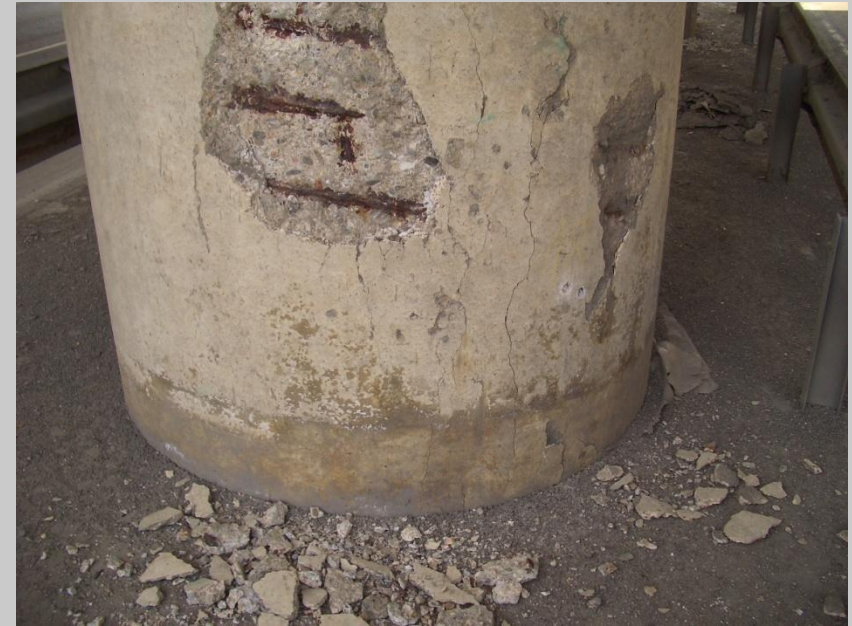
Abbildung 6: Ansicht Stütze FR Eselsberg April 2010
