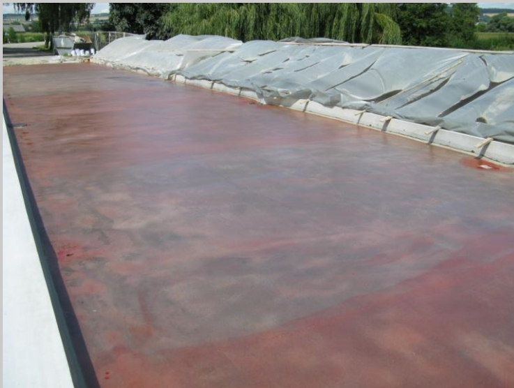
Abbildung 11: Sanierung Fahrbahntafel am Beispiel Donaubrücke Gögglingen
