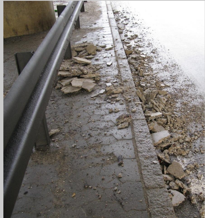
Abbildung 3: Entfernen loser Betonteile im Dezember 2009
