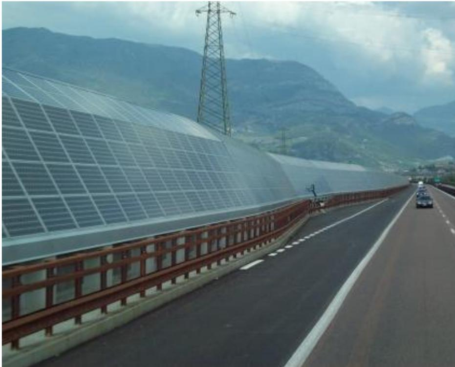
**PV-Anlage auf Lärmschutzwänden**
