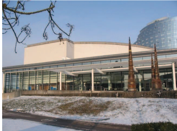
Foto 88: Basteistraße 40 - Congress Centrum
