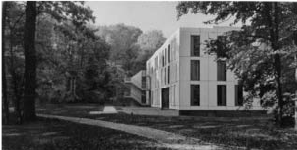
Neubau der Psychosomatik fertiggestellt im November 2012, Tiemann-Petri und Partner, Stuttgart
