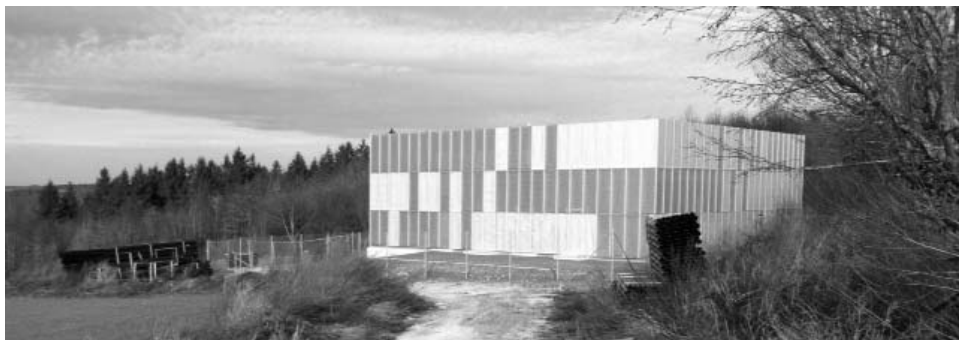
110/20 kV-Trafo nördlich des Berliner Rings, NGP-Architekten Neu-Ulm
