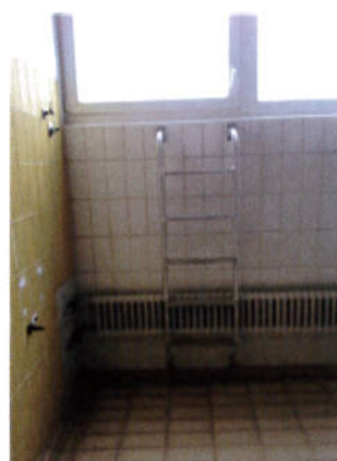
Notausstieg der Schwimmhalle
