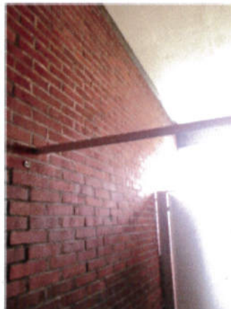
Wandflächen in den Umkleiden
