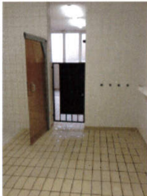
Durchgang von der Umkleide zu den Duschen
