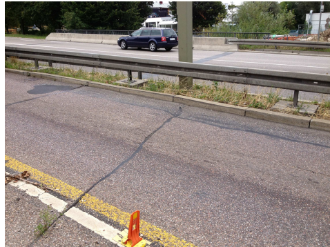
Schäden an Plattenfugen / Spurrillen
