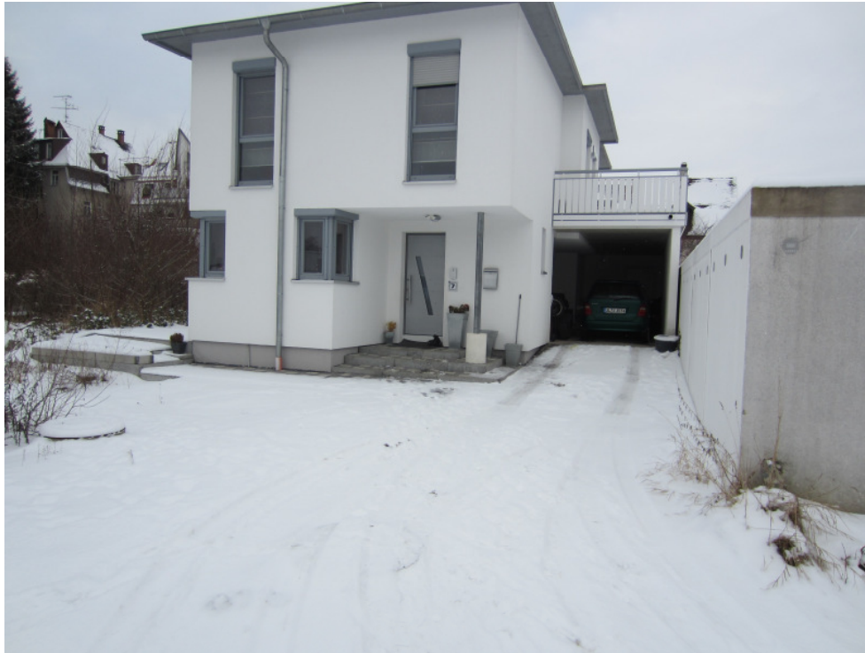
Bild 5: Gebäude „Haus Nr. 7“
