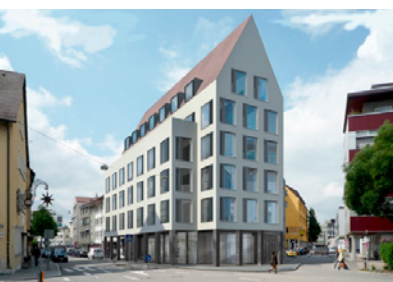
5.2 Neubau Wengengasse Keltergasse
