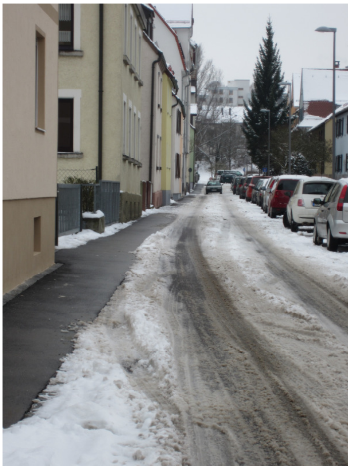
Bild 10: Meinlohstraße, Blick von Norden
