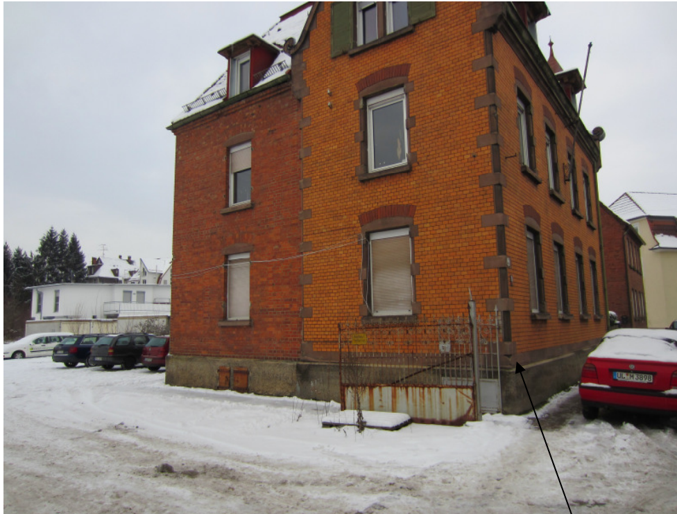
Bild 17: Gebäude Klingensteiner Straße 57
