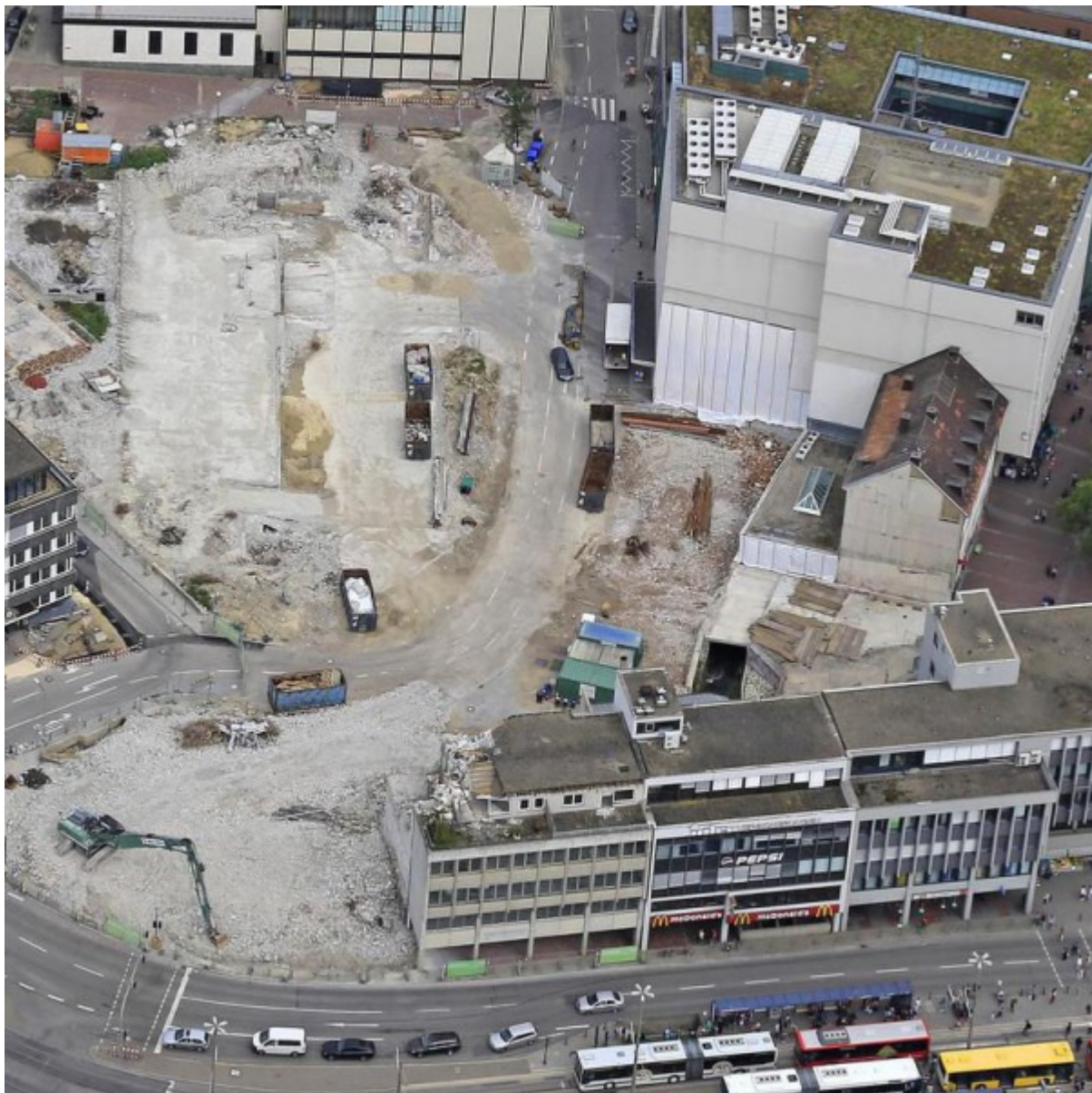
Luftaufnahme der Baustelle am Bahnhofplatz. Fotograf: Siegfried Geyer
