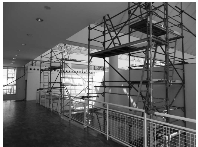
Baugerüst zur Innensanierung
