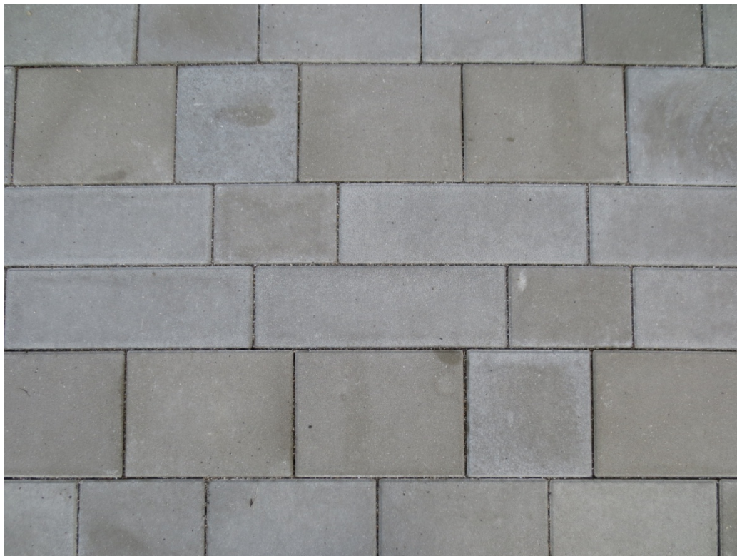
Betonpflaster in Bahnenverlegung: Formate 45/15, 30/15, 22,5/22,5; 30/22,5
