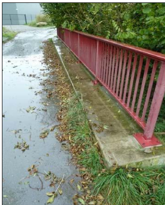
Mangelnde Entwässerung
