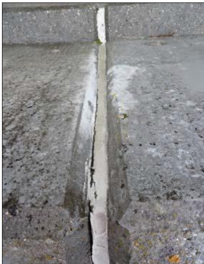
Defekte Abdichtung in Brückenkappen
