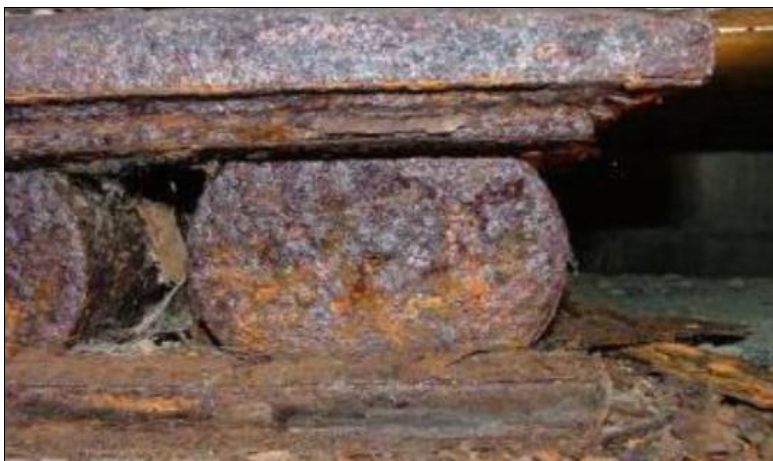
Korrodiertes Lager
