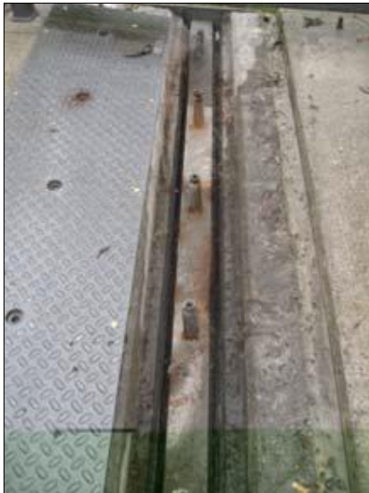
Defekte Abdichtungen in der Übergangskonstruktion
