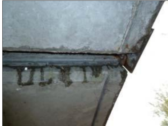
Defekte Abdichtungen in der Übergangskonstruktion
