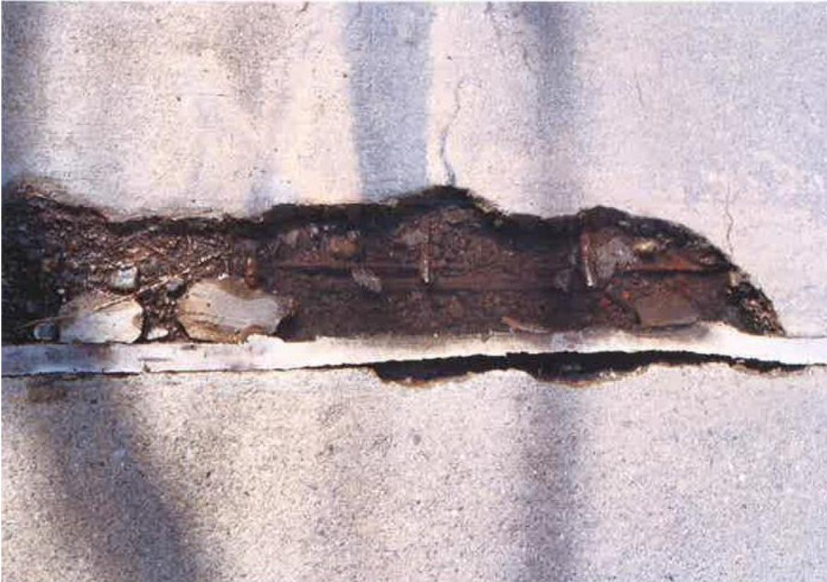
Stehende Feuchte in Schadstellen der Zufahrtsrampe, mit freiliegender, korrodierter Bewehrung
