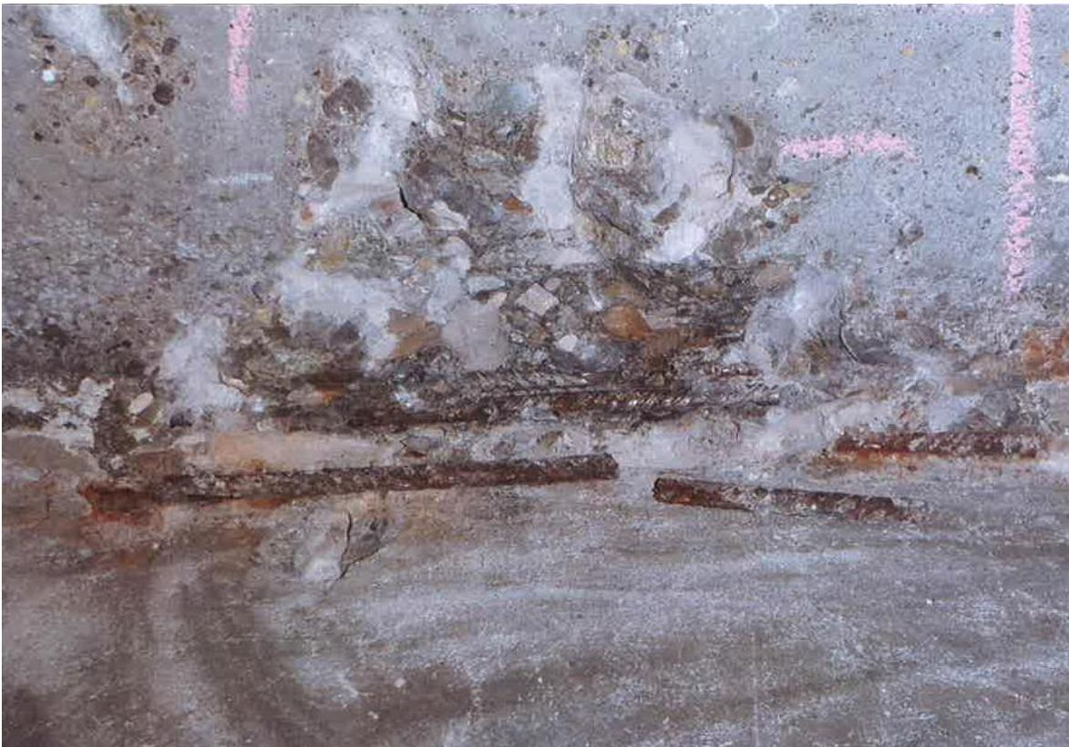
Wandfuß im Übergang zu Bodenfläche mit Spuren stehender Feuchte, Betonabplatzungen und korrosiven Verfärbungen
