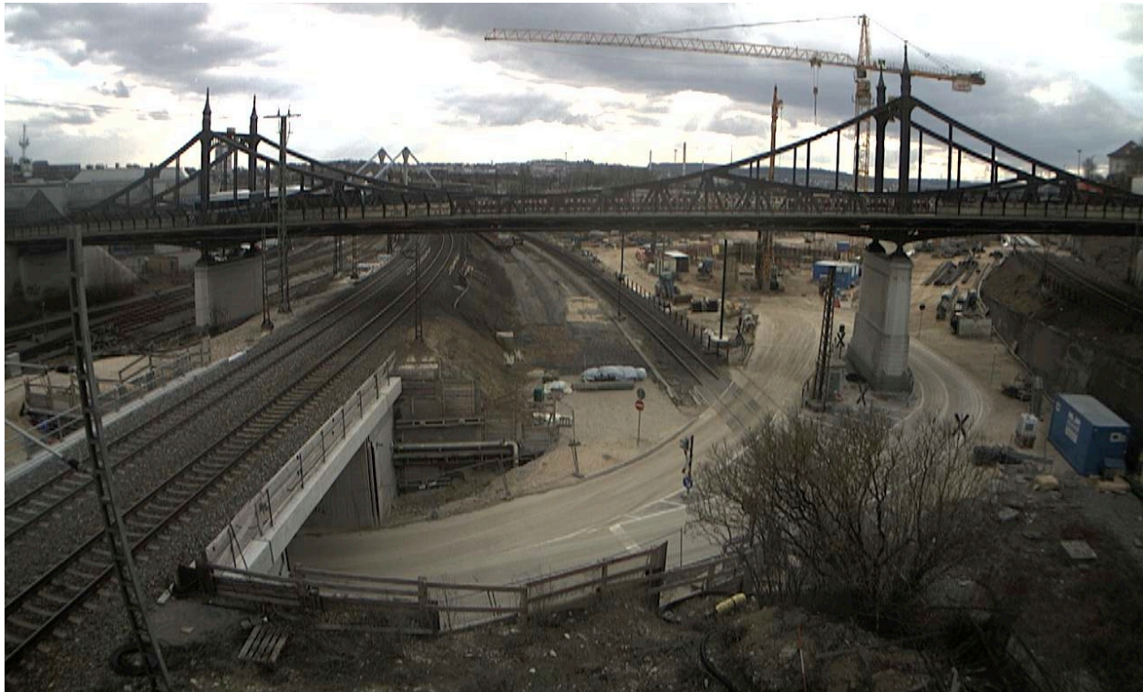
Abbildung 4: Webcambild Eisenbahnüberführung (EÜ), Rettungspplatzzufahrt 8
