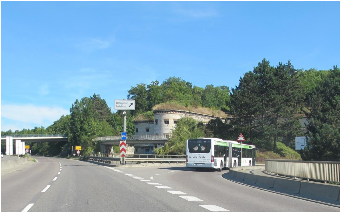
Bilder vor dem Abbruch der Brücke beim Alten Fritz
