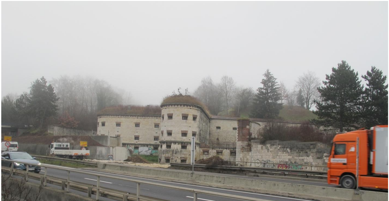
Bilder nach dem Abbruch der Brücke beim Alten Fritz
