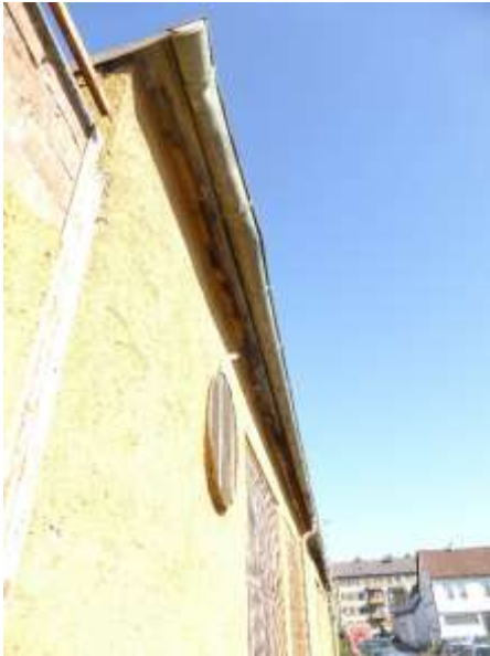
Mittlere Halle, Ostseite an Kleiststraße.
