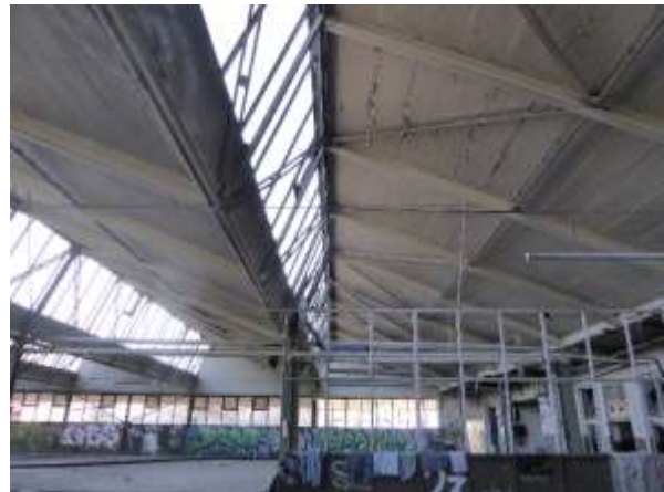
Vollständig unterkellerte mittlere Halle hinter Bürogebäude.
