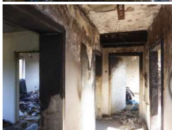
Verschiedene Räume des Bürogebäudes – in verschiedenen Zuständen.
