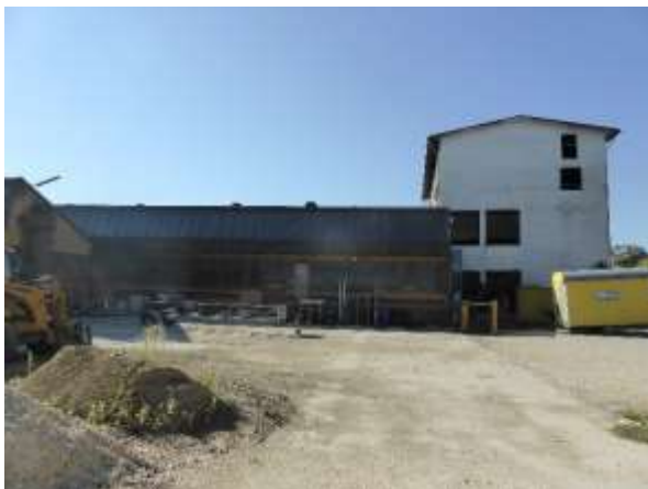
Blick aus dem Hof von Norden: Rechts Bürogebäude, mittig mittlere Hallen, links nördliche Hallen.
