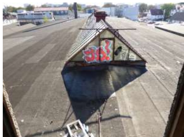
Mittleres Hallendach vom Bürogebäude aus.
