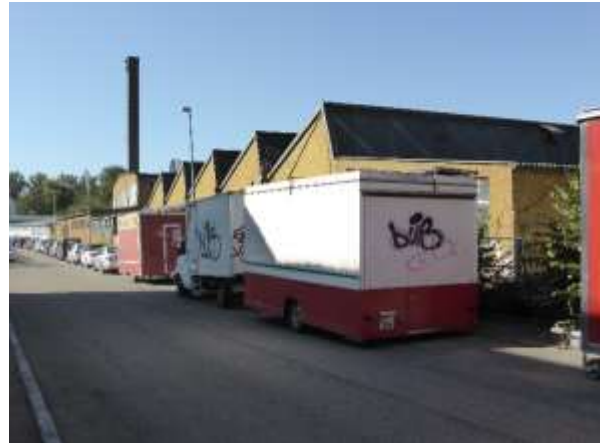
Blick von der nördl. Kleiststraße auf den Gebäudekomplex.
