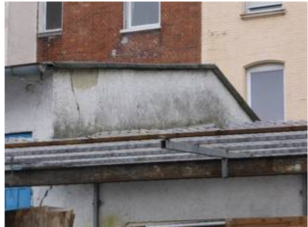
Vordach in der Ecke des Hallen-Trakts.
