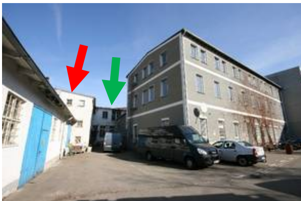
Blick vom Container entlang der abzubrechenden Hallen, im Hintergrund links das dreistöckige Gebäude, das ebenfalls abgebrochen wird (roter Pfeil), daneben zu erhaltender Gebäudeteil (grüner Pfeil).
