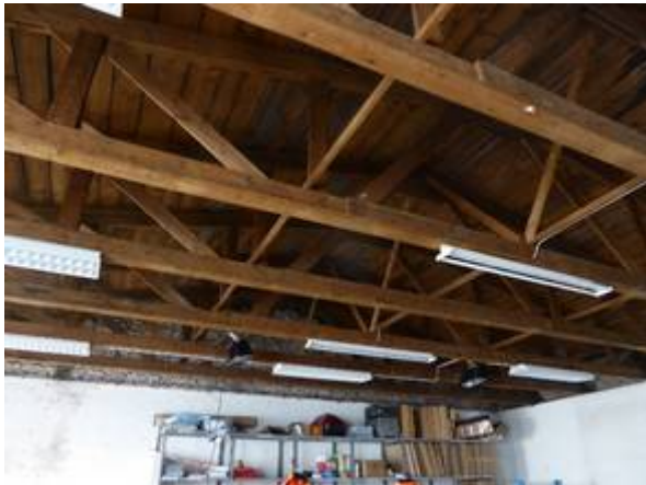
Hallen-Dach von innen, Süd-Trakt.
