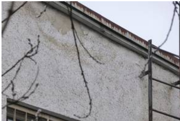
Oberkante der Südfassade des „Mittelbaus“, minimale Fuge zwischen Blech und Mauer.
