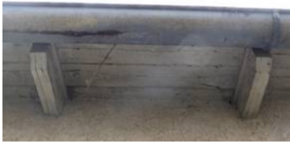
Dachüberstand der Hallen-Westseite am Hinterhof, ohne Lücken, Fugen o. ä.
