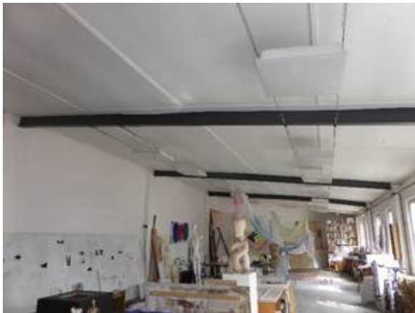
Dach des zu erhaltenden Gebäudes, ähnlich „Mittelbau“.
