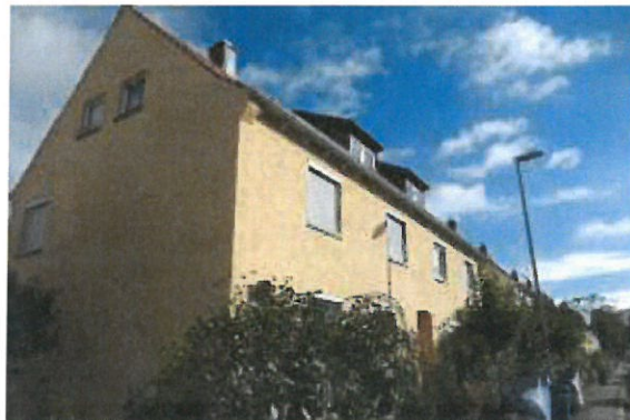
Westlichstes Haus Wamdtstr. 28, Südseite an der Straße, Blick in Richtung der übrigen Häuser
