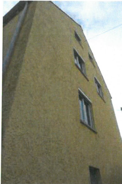
Westseite des Hauses Warndtstr. 14.
