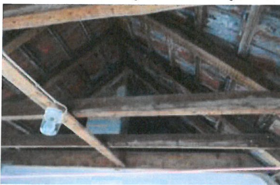
Die nicht isolierten Dächer waren innen hell, da alle mit Fenstern oder Gauben versehen, und dicht.
