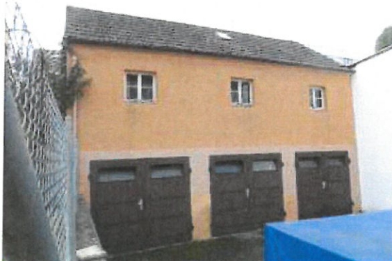
... und untere Etage von der Saarlandstraße aus.
