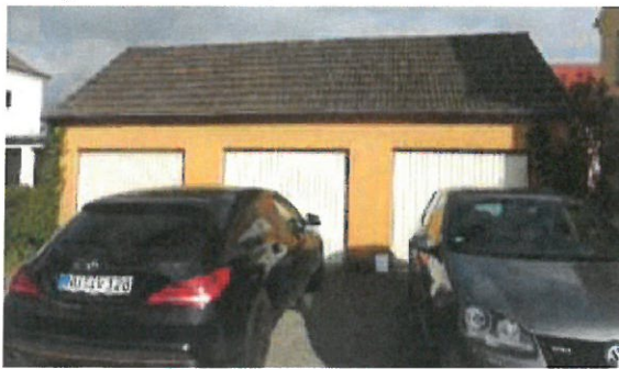
Westlichste Garage, obere Etage von der Wamdtstraße aus befahrbar ...
