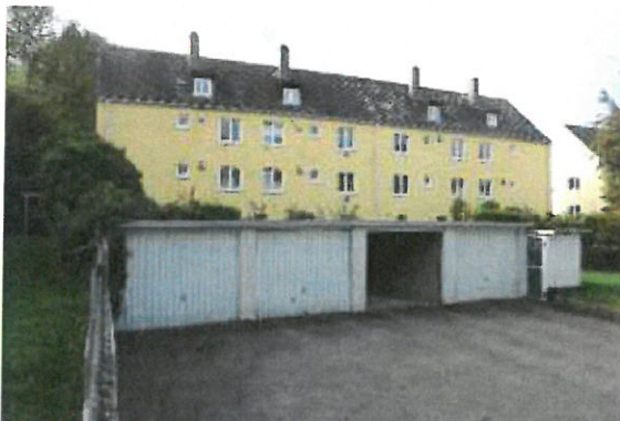
Haus Warndtstr. 12+14 von Norden, davor die östlichste Garage an der Saarlandstraße, die ebenfalls abgerissen wird.
