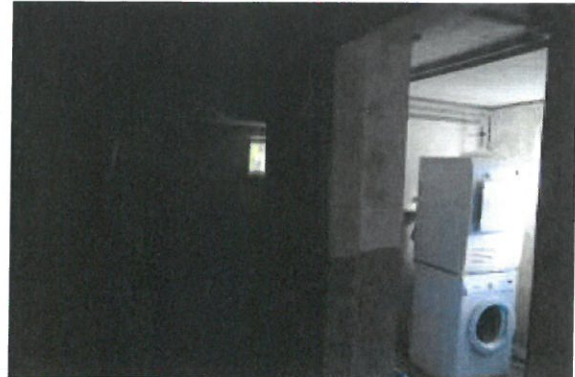
Auch die Keller (hier nordseitig) hatten alle Fenster ...
