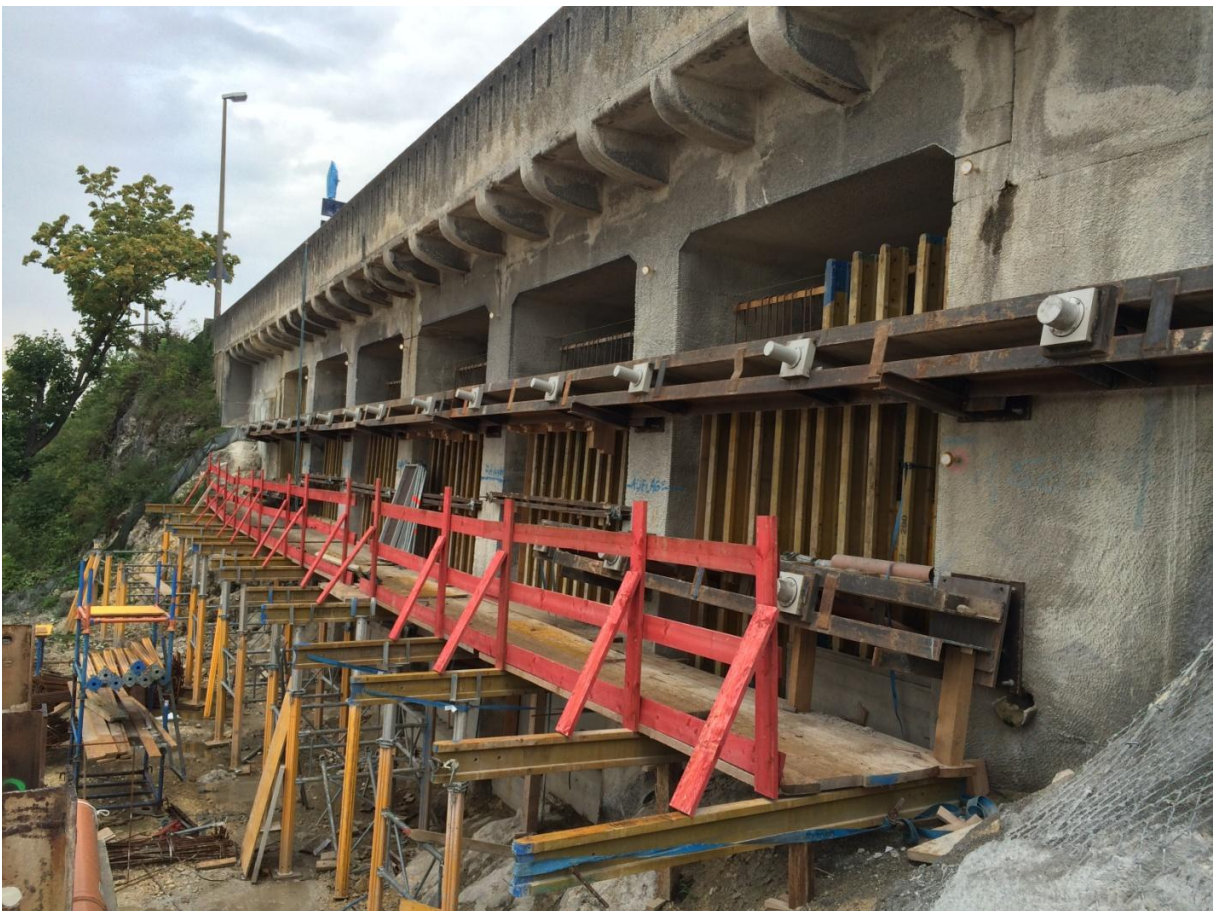
Einbau der Felsanker und Betonplomben 2015
