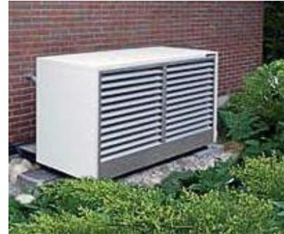
Abbildung 15: Außengerät einer Luft/ Wasser-Wärmepumpe (Quelle: swisstherm)
