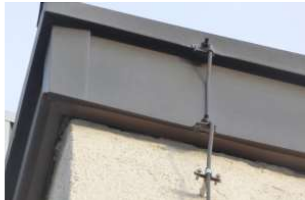
Dachabschluss von Gebäude 8: sauber verblecht.
