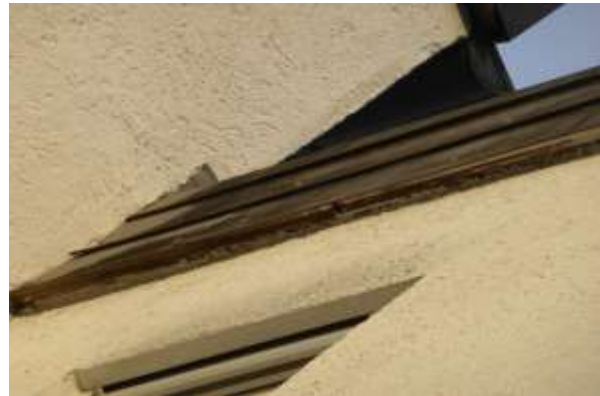
Wieder dicht abgeschlossene Dachkantenverkleidung.
