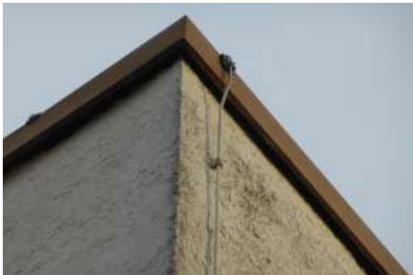
Dto., Dachkante verblecht, innen abgedichtet.
