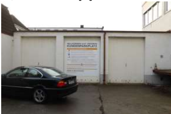
... Gebäude 12a: Garagen.
