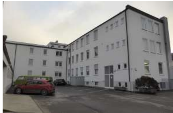
Gebäude 8 (rechts) und 9 (links hinten), Blick von Norden.
