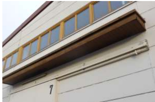
Dachüberstand auf Westseite, holzverkleidet ...
