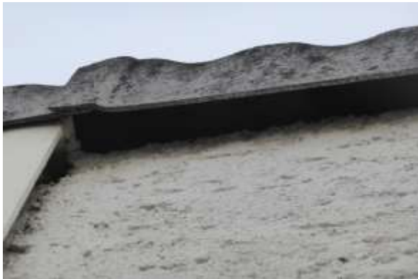
... mit Fuge an Dachkante und rauem Putz.
