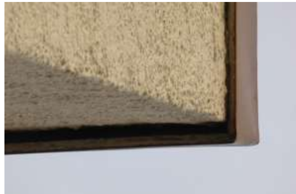
Dachüberstand mit Spalte, aber abgedichtet.
