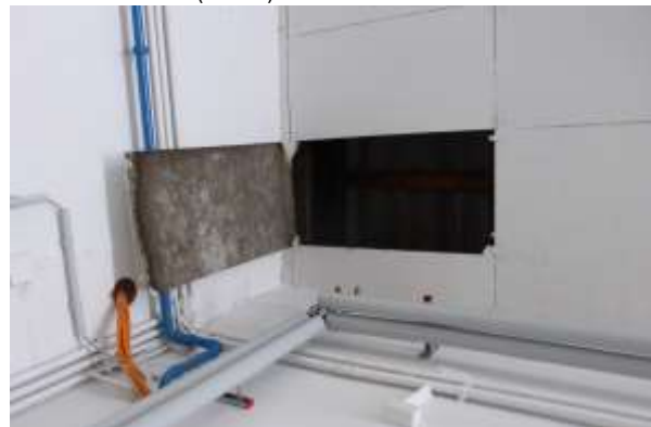
Gebäude 13, abgehängte Decke von innen.
