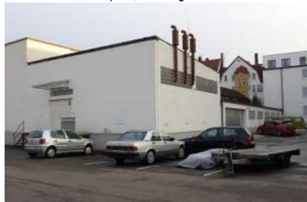
Gebäude 13 und (rechts) 14 von Nordwesten.
