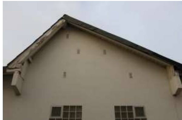
Dto., Giebel auf Südseite.
