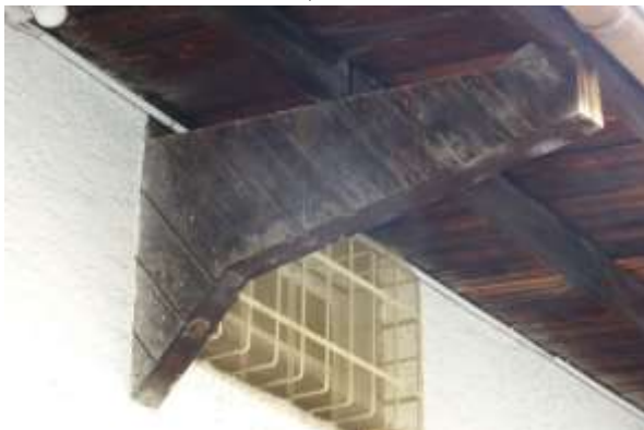
Dachüberstand auf der Südseite von Gebäude 11 mit oben offenen, verkleideten Balken.
