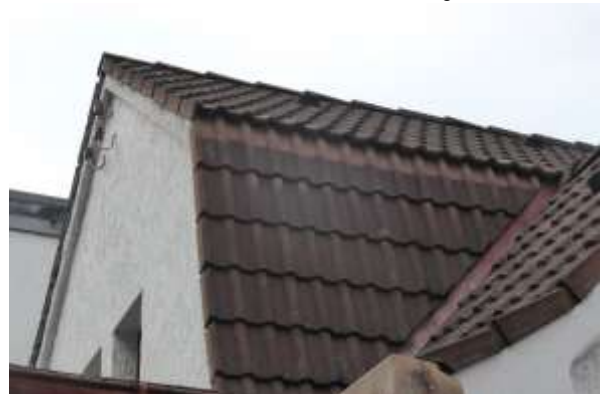
Gebäude 10, Dach, Südseite.
