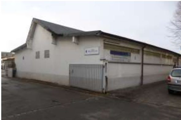
Gebäude 1, von Südosten
