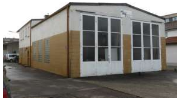
Gebäude 4 und 5 (hinten) von Nordosten ...
