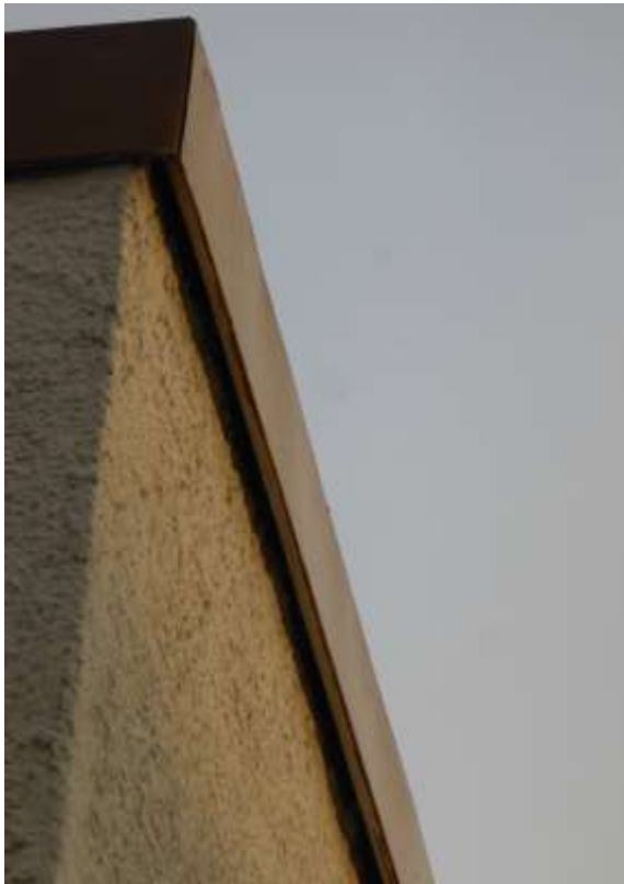
Dachkantenabschluss von Gebäude 9, Blech, glatt, innen abgedichtet.
