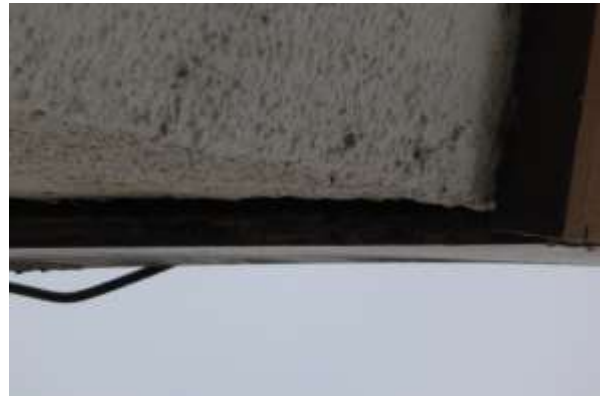
Verblechung an Dachkante dicht anliegend.
