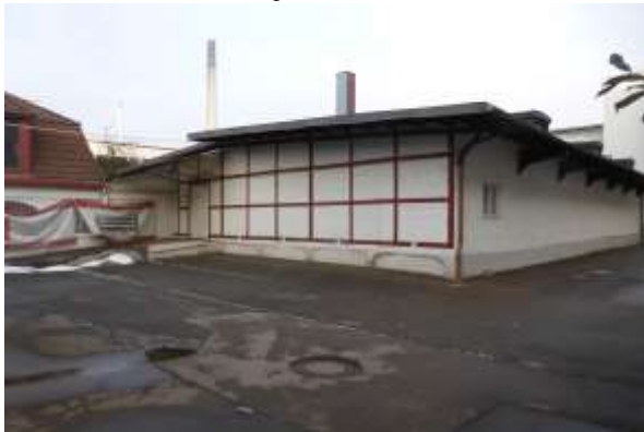
Gebäude 11 von Südwesten, links noch Gebäude 10.
