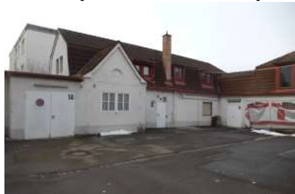
Gebäude 10 von Osten aus.
