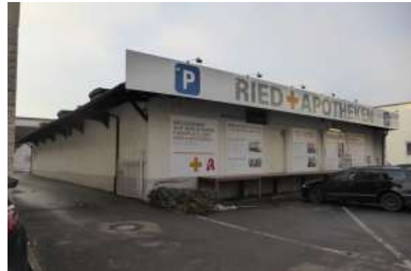
Ostseite von Gebäude 11 ...
