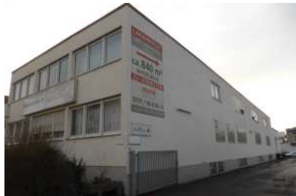
Gebäude 12, Ost- und Nordseite.
