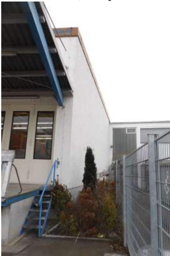
Gebäude 3a, Nordostecke.
