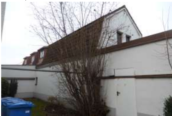
Gebäude 10, von der Südostecke des Gebäudes 9 aus.
