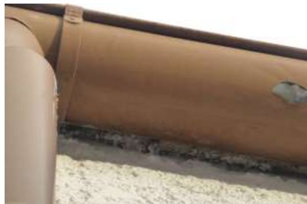
Dto., Dachrinne liegt fugenlos an Hauswand an.
