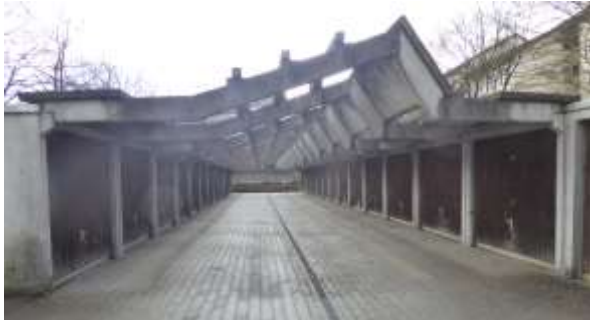
Diese Garagendoppelzeile wird abgebrochen.
