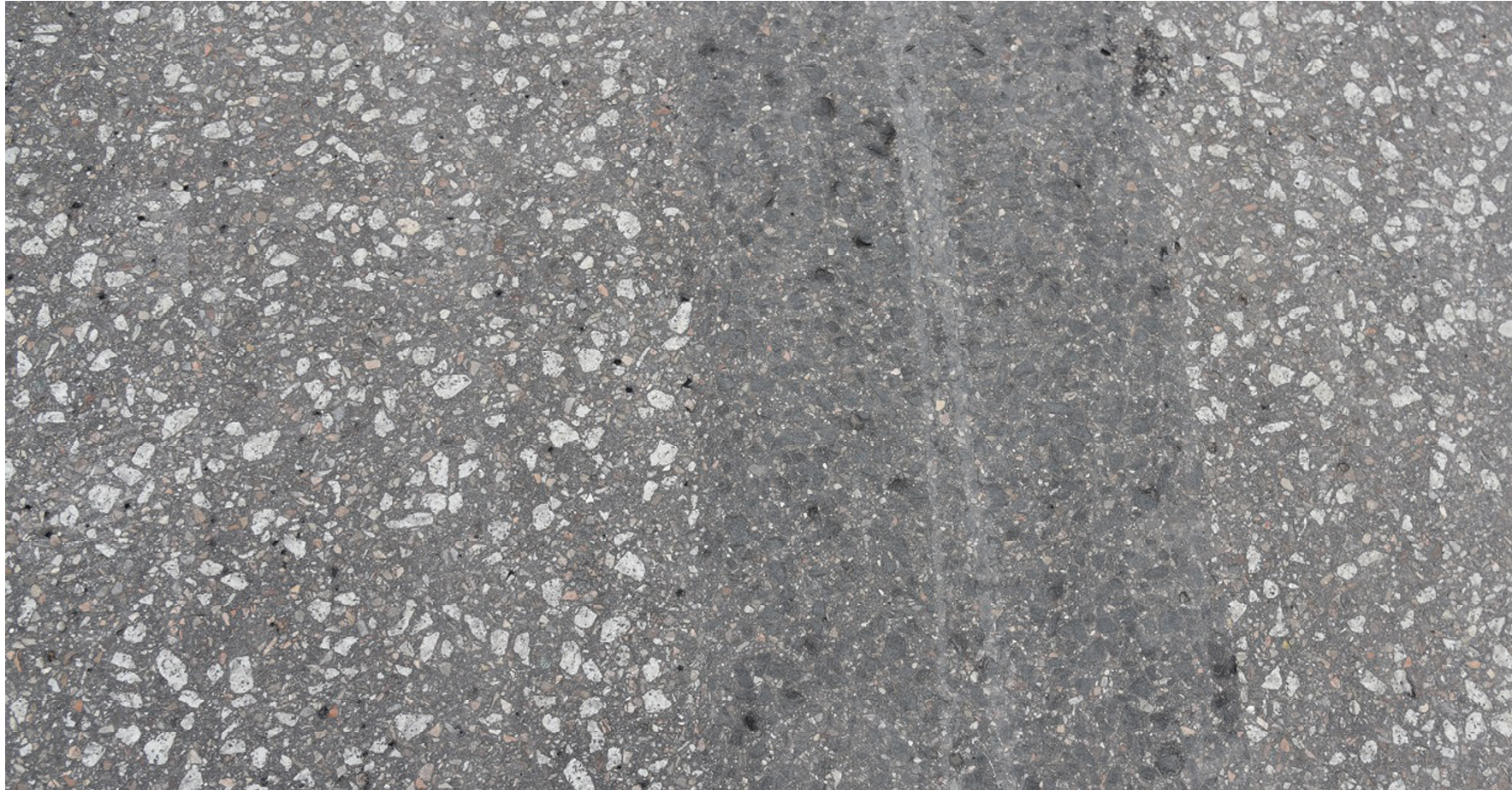
Platzbelag Asphalt Beispielfläche Archhöfe Winterthur, Schweiz
