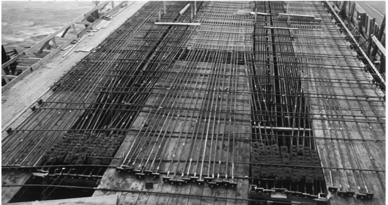
Bild vom Einbau der Längs und Querspannglieder
