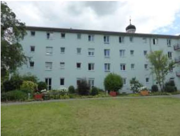
Westtrakt, Ostseite vom Innenhof aus.
