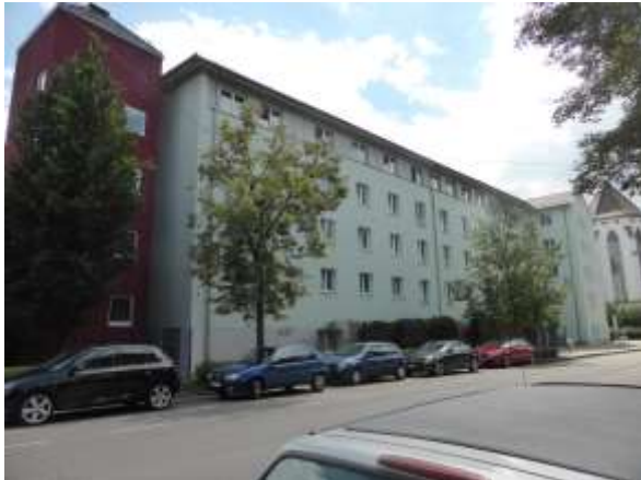
Gesamtansicht der abzubrechenden Gebäudeteile von Nordosten. Fassade glatt, keine Fensterläden oder Rollläden, auch im Dachvorsprung keine Lücken.
